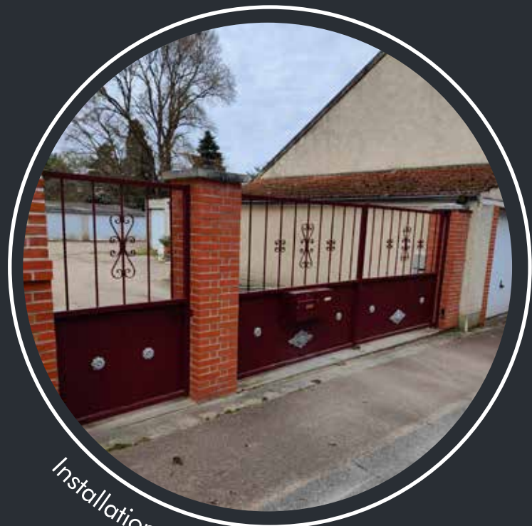
Installation d'un portail
